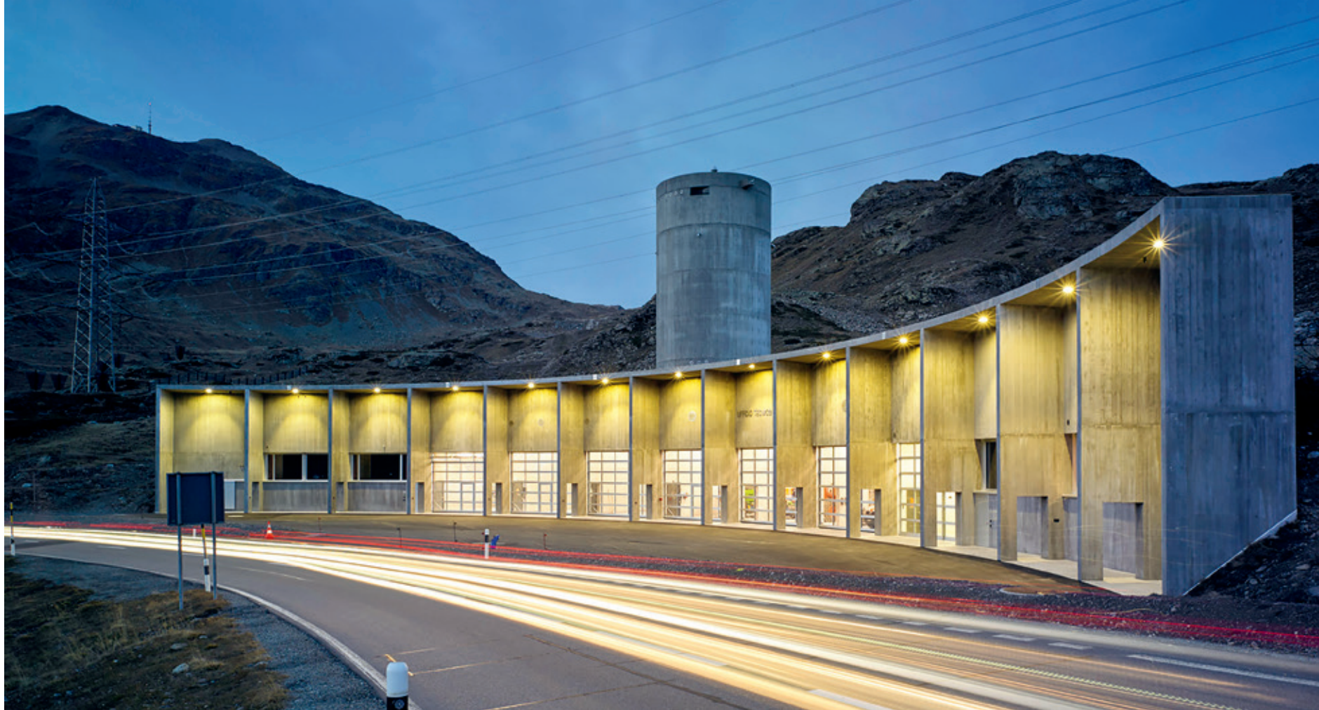
Der Unterhaltstützpunkt, realisiert von Bearth & Deplazes, auf dem Berninapass dient der Sicherung der Strassenverbindung ins Puschlav.
