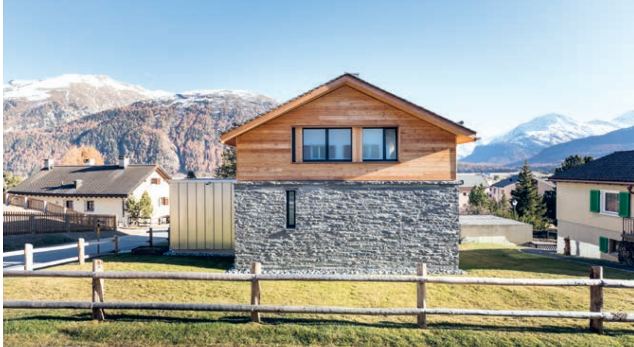
Die Passerelle erschliesst das Haus von der Strasse her.
