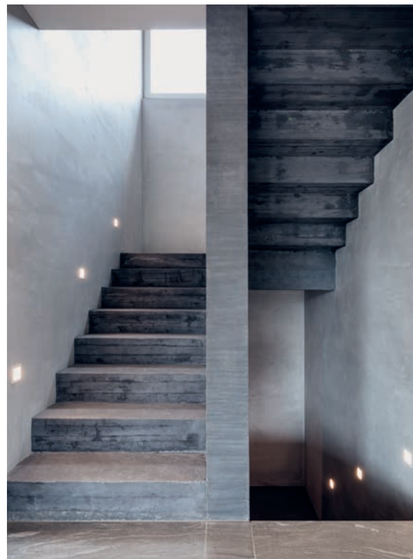
Herzstück ist die negativ geschaltete Treppe.
