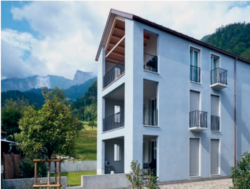
Kleine angebaute Balkone geben den Blick in den gepflä- sterten Innenhof frei.
