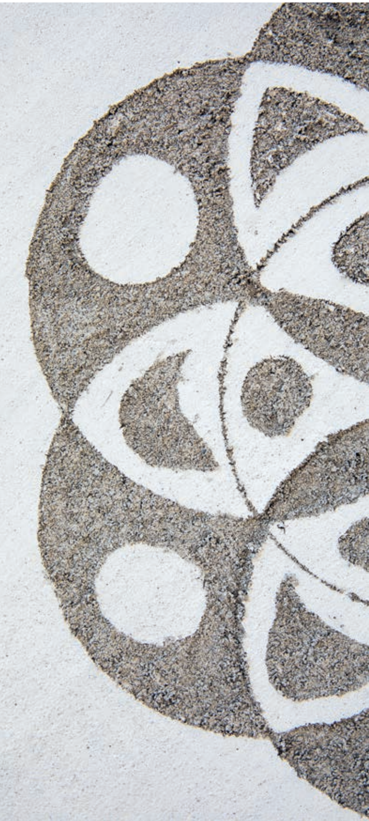
Bei Scraffiti werden aus einer feuchten, mit hellem Kalkanstrich übertünchten Putzschicht mit Stiften und Messern Ornamente gekratzt.
