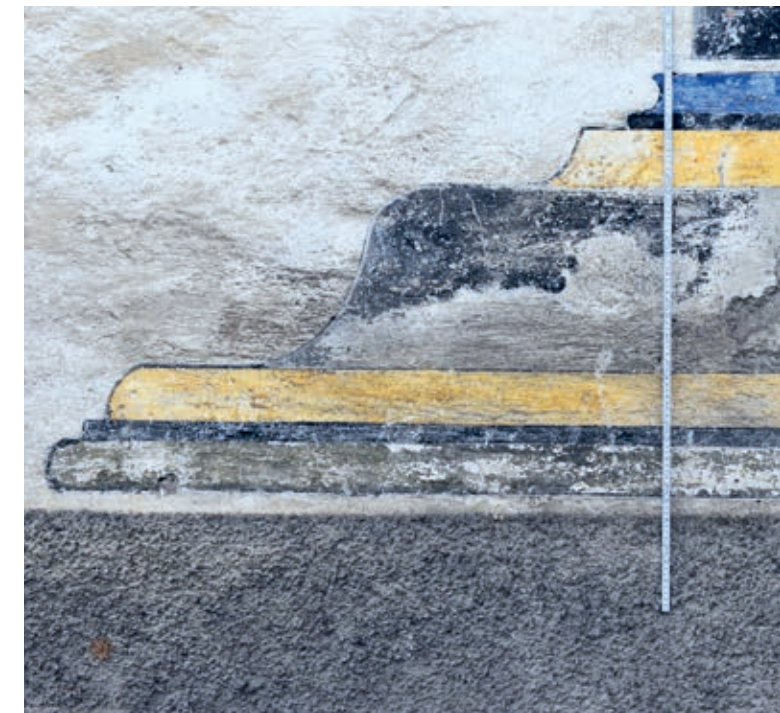
Das Natureinmauerwerk ist mit grauem Luftkalkmörtel und Fassadenmalereien überzogen.
