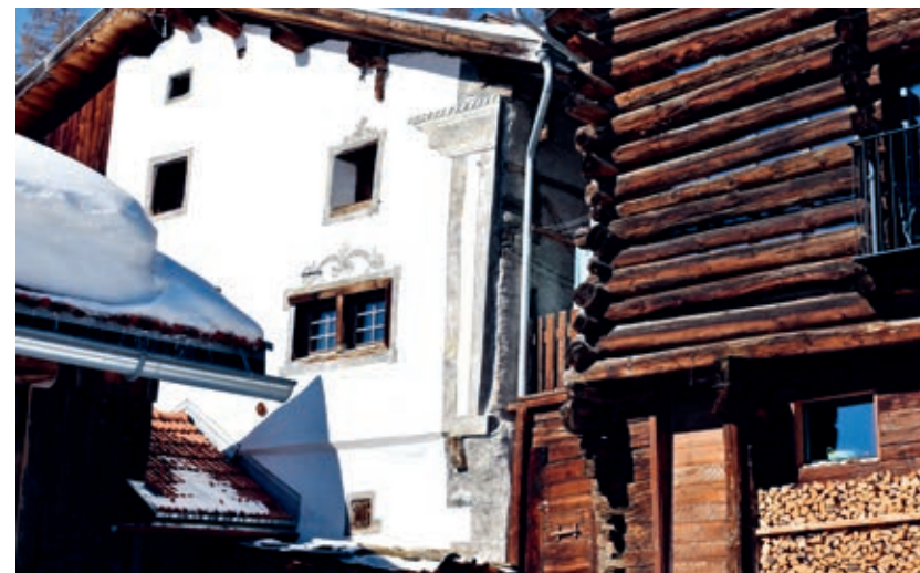
Für die Restaurierung wurde Kalkputz eingesetzt.
