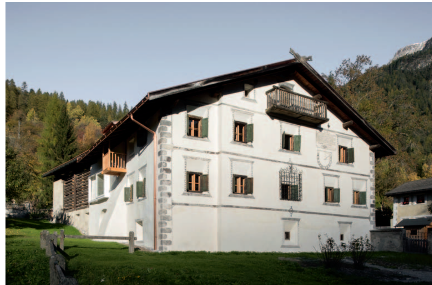
Das Haus F in Filisur mit dem davor liegenden Garten nach der Restaurierung.
